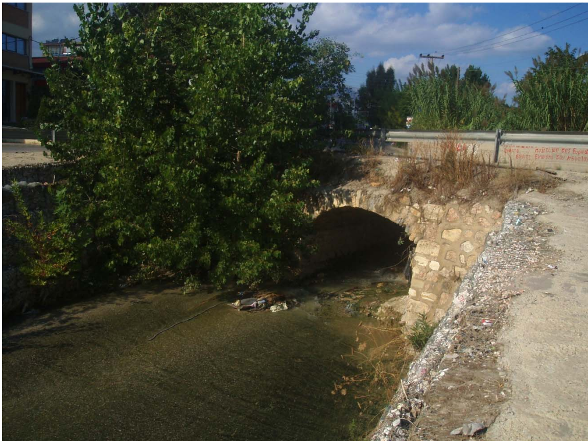
Εικ. 93 Χαρακτηριστικά μικρή διατομή κατά μήκος του ρέματος της Εσχατιάς στη διασταύρωση Καρυταίνης και Φυλής.
